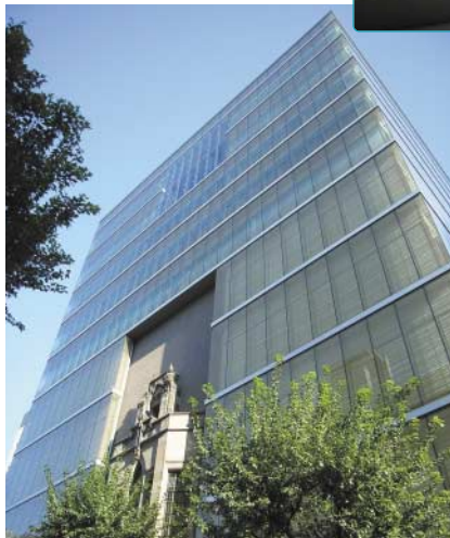
建て替え事業で出窓を保存した交詢ビルディング。ガラスの接合部はコーナーを含めてシーリング材だけで成立させた
